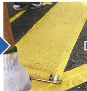
専用のローラーを用いて塗布面にパターン（凸凹）付けし、仕上げます。
