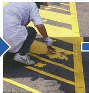
塗布面をゴムベラ等で均一にし、約1~2mm厚程度に塗り広げます。
